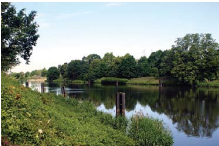
Kanał Gliwicki poniżej śluzy Łabędy
